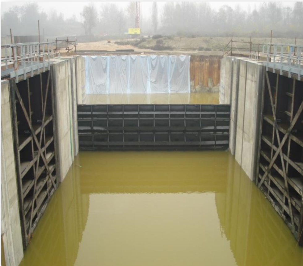
Figura 5 – Chiusa in costruzione
